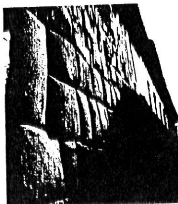
Cuzco (Perù), muro incaico.
