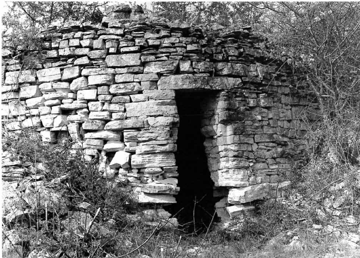
Capitelle possédant une date gravée : 1702, à SAINT-PRIVAT-DE-CHAMPCLOS.
