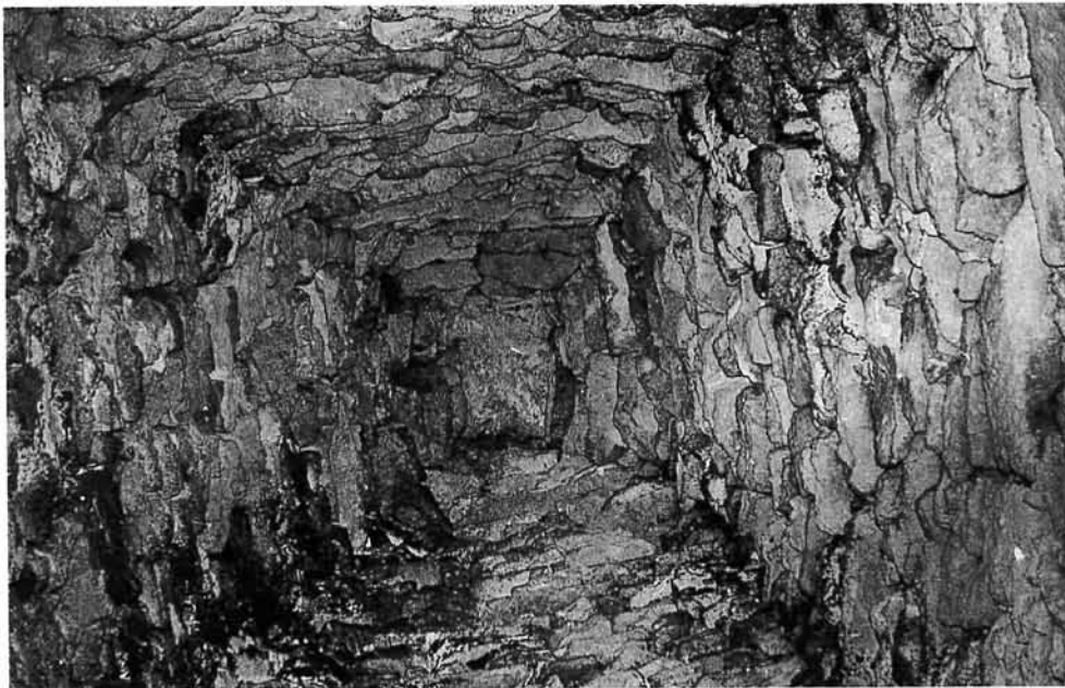
Vue de l'intérieur d'une voûte à encorbellement carré.
