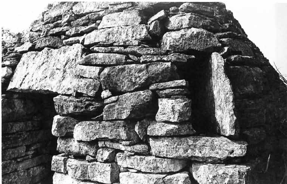
Vue de l'extérieur.
