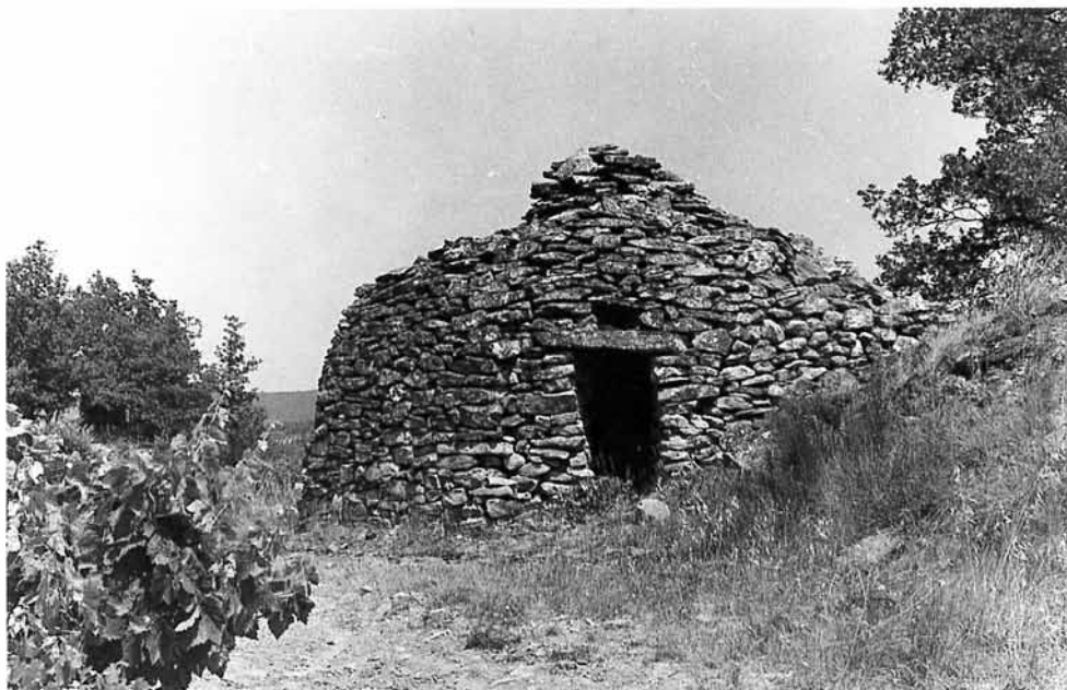
Capitelle ronde surmontée d'une coupole à SAINT-ETIENNE-DE-L'OLM.
