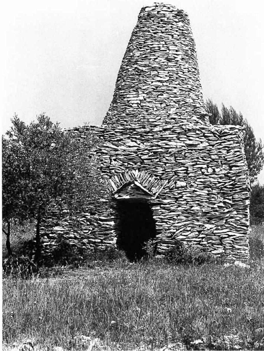
Cabane à grande coupole "obusoïde". Remarquer l'emploi de petites pierres.
