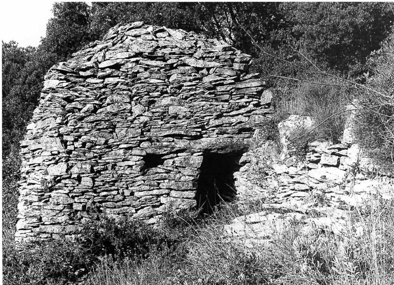
Construction accolée à un mur de soutènement à SAINT-ETIENNE-DES-SORTS.
