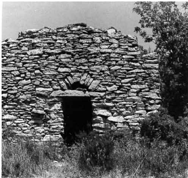
AUBAIS L'arc de décharge en voûte clavée à pierre sèche est rare car il est difficile à réaliser. Il est confectionné à partir de plaquettes brutes disposées sur un cintrage en bois provisoire. Les joints des pierres sont dirigés vers le centre du demi-cercle et la pierre supérieure verticale forme la "clef de voûte".
