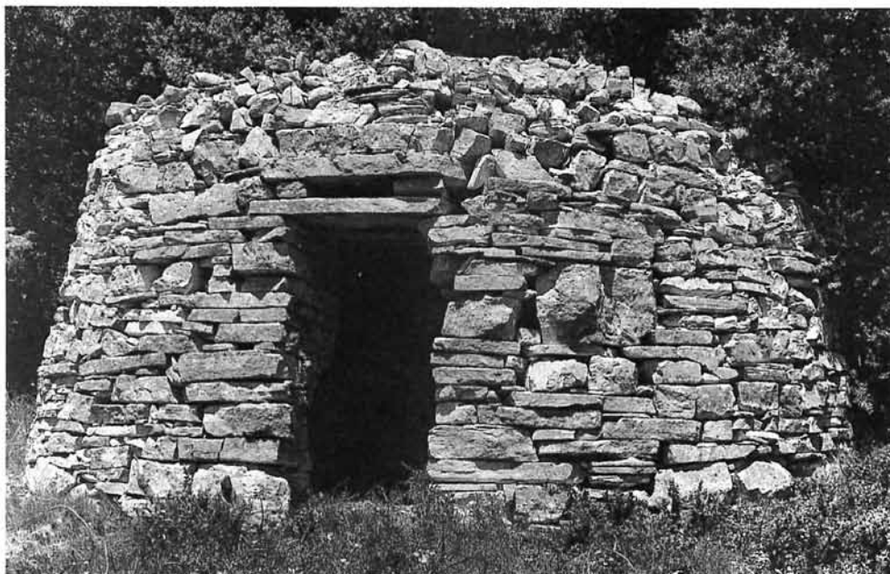
Double linteau à arc de décharge rectangulaire.
