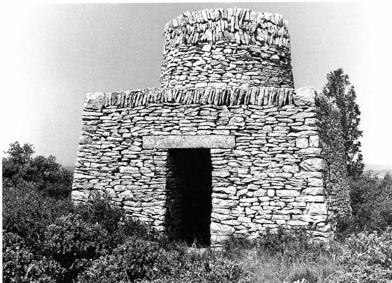
Construction dite "la cabane de Malais" à SOUVIGNARGUES.
