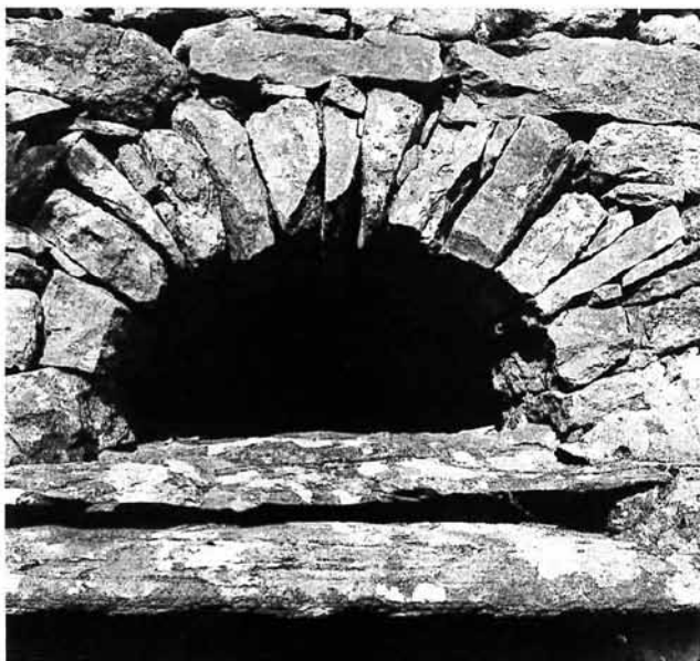
AUBAIS L'arc de décharge en voûte clavée à pierre sèche est rare car il est difficile à réaliser. Il est confectionné à partir de plaquettes brutes disposées sur un cintrage en bois provisoire. Les joints des pierres sont dirigés vers le centre du demi-cercle et la pierre supérieure verticale forme la "clef de voûte".
