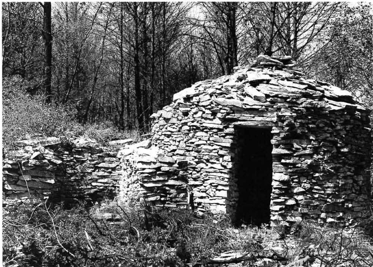
Capitelle ronde accolée à une construction rectangulaire (écurie ?) à MARGUERITES.
