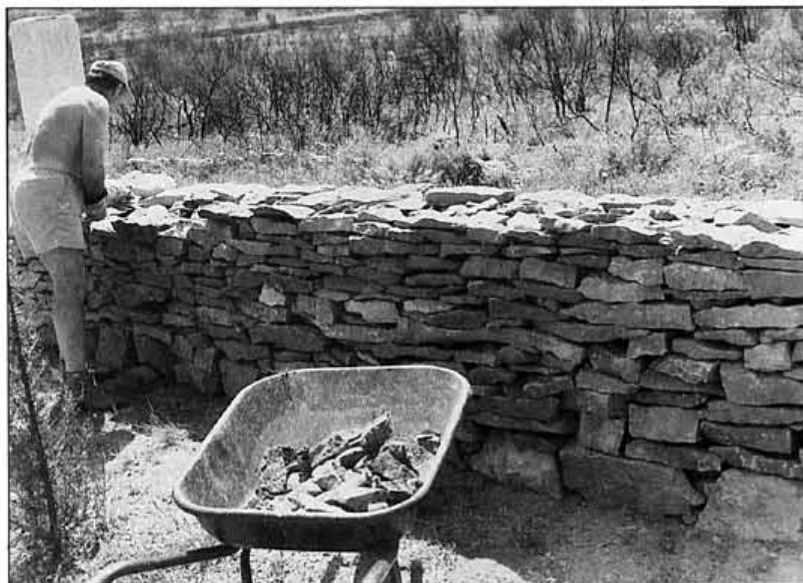
Cadelon ouest Construction d'un mur en pierres sèches (mars 1990)
