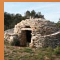
de pierres plates disposées pour former des assises circulaires, chaque assise reposant en surplomb sur la précédente. Les pierres sont posées inclinées vers l'extérieur pour assurer l'étanchéité. Une grande pierre plate termine la fausse voûte.
