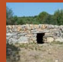
Encastrée dans un clapas, cette petite construction à l'ouverture basse, permettait à un homme assis de s'abriter. Les murets en délit (avec les pierres supérieures posées perpendiculairement au sol) empêchaient les chèvres de sauter. Cette disposition avait pour but de coincer les pattes de l'animal.
