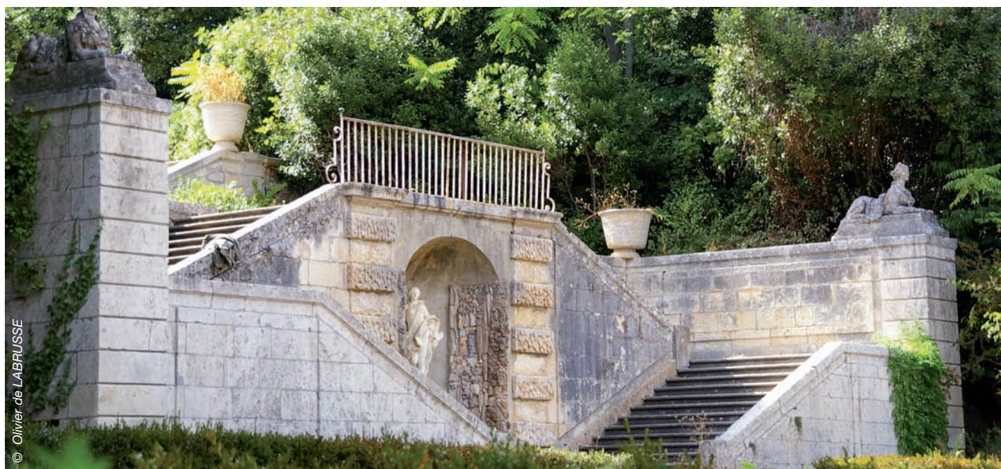
Ph. 33 Grand escalier
