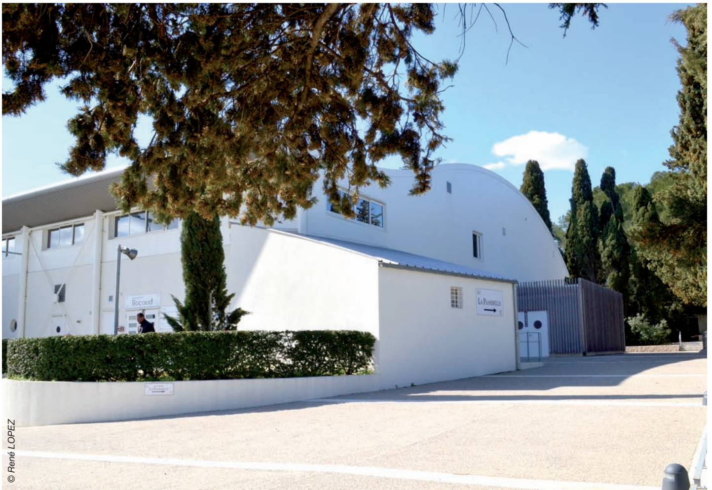
Ph. 20 La Passerelle, salle de spectacle
