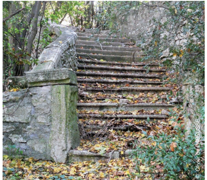
Ph. 53 Escalier 18 e siècle des terrasses au nord
