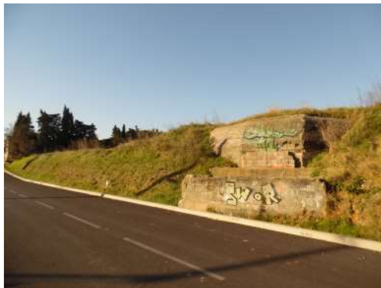
Perols, le Soriech. Blockaus du « Südwall » (Photo O. de Labrusse)
