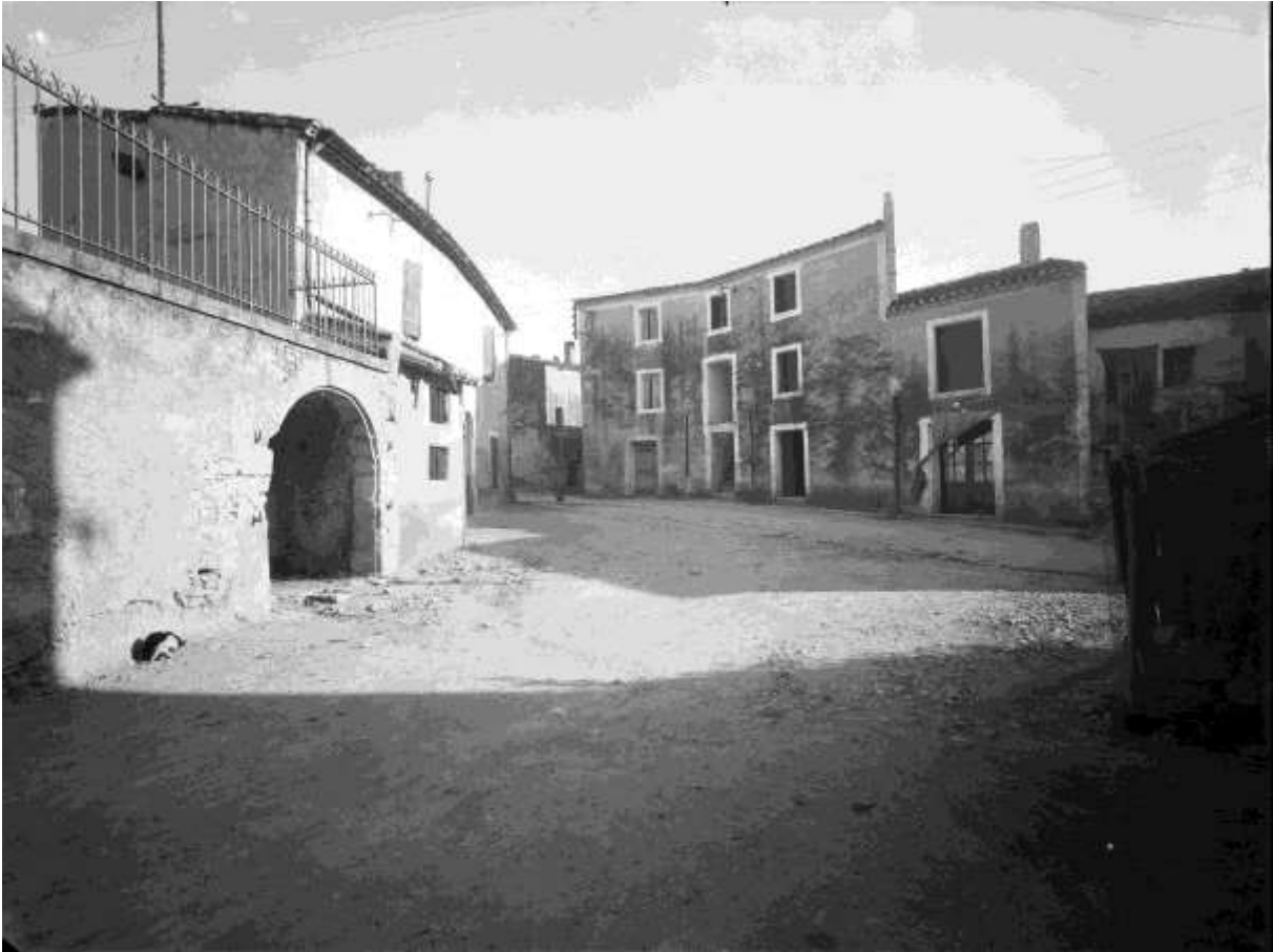
Place du château et rue de la chapelle. Non datée. ( Archives du château de Jacou )
