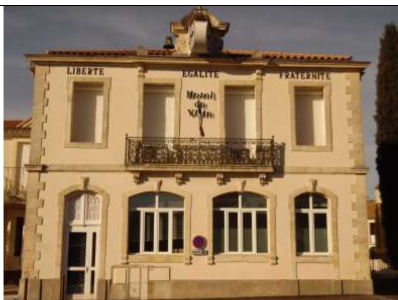
L'actuel hôtel de ville de Jacou, ex- « mairie-école ». Au rez de chaussée l'unique salle de classe avec ses 3 fenêtres), à l'étage le logement de l'institutrice, Me OLIVIER
